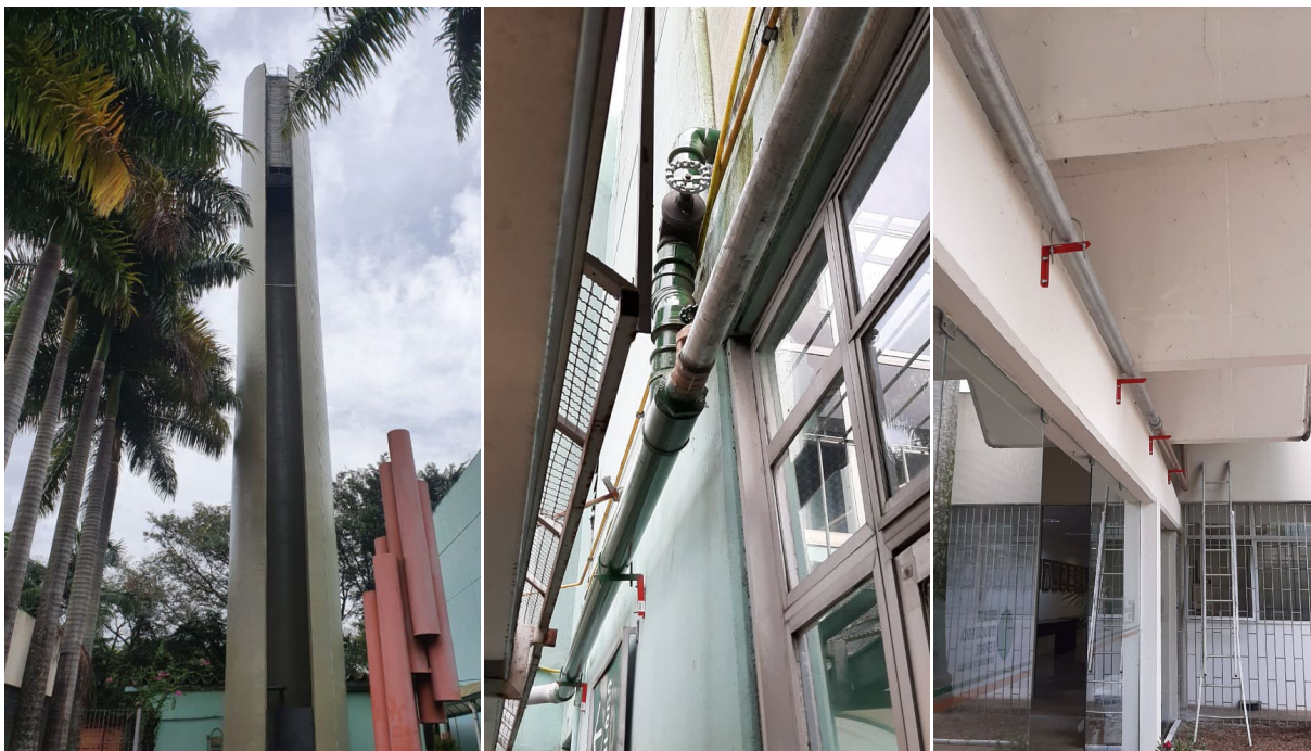
Serviço de reparo no sistema hidráulico e na rede elétrica.
