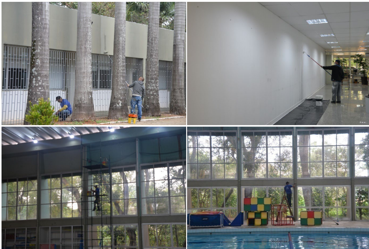
Pintura interna e externa dos Blocos A, B e C.
