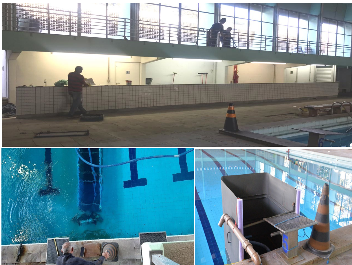
Obras voltadas à correção dos vazamentos da piscina e à modernização e adequação do espaço.
